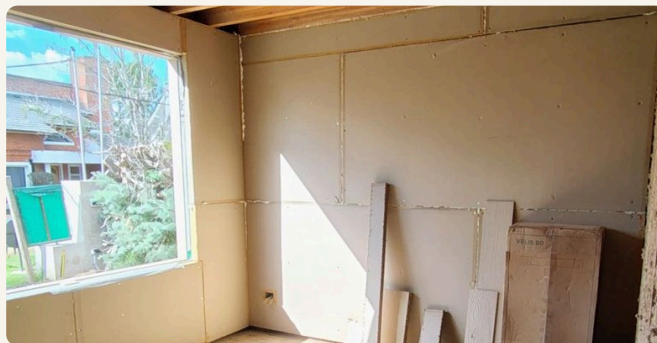
La misma obra con las placas como hoja interior del muro.
