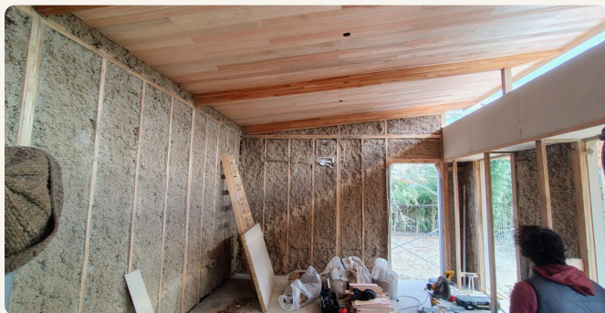
Entramado de madera con la aislación colocada, antes de cerrar. Casa en Escobar, Buenos Aires.
